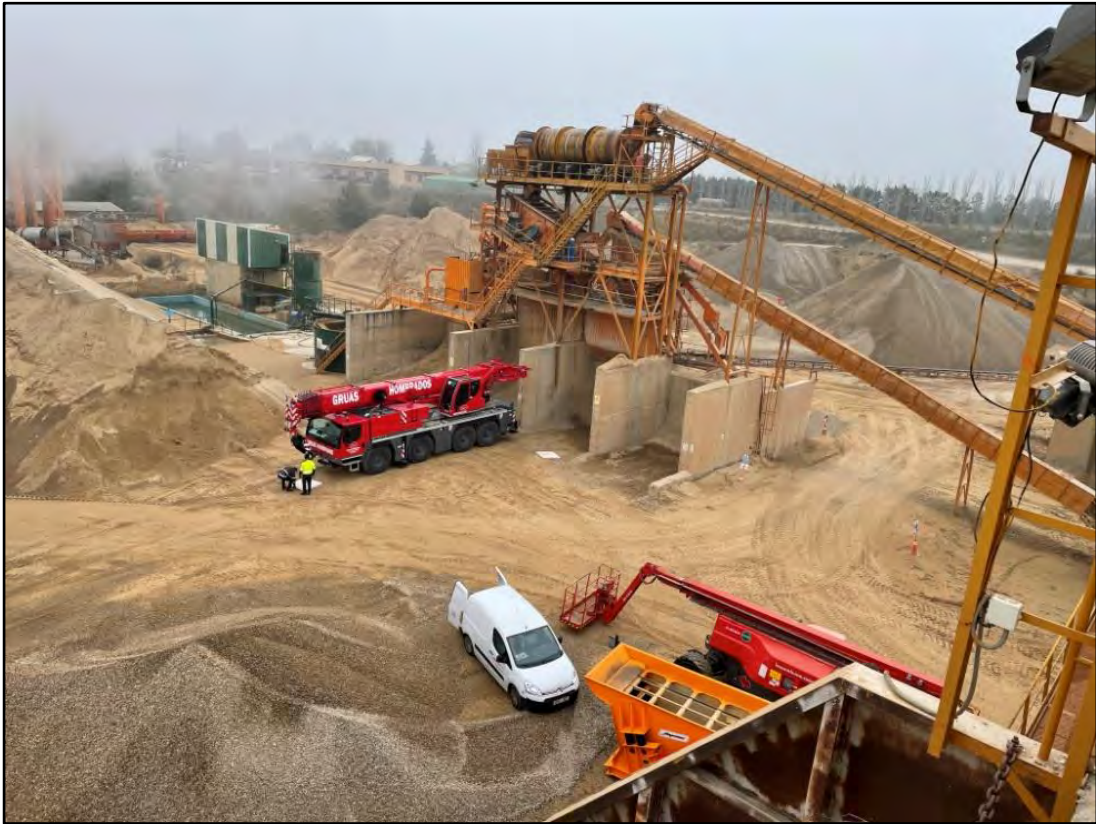
Vista parcial de las instalaciones de tratamiento.
